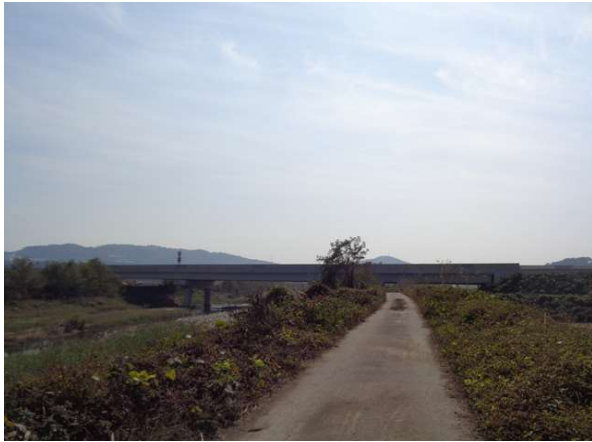
교량 측면 전경
