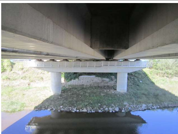
교량 하부 전경
