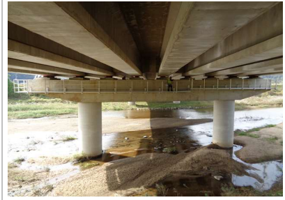
▲ 교량받침 점검로 근접조사
