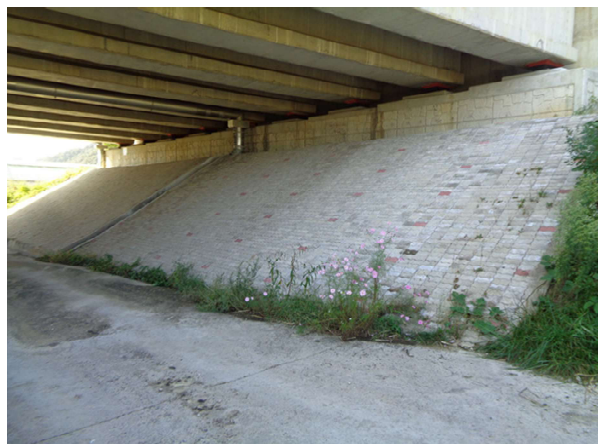
교량 하부 전경
