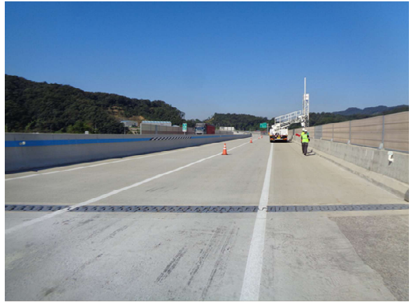
교량 상부 전경
