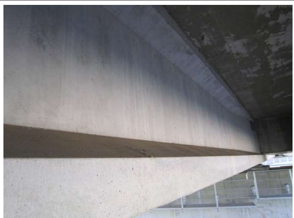
교량 거더 전경
